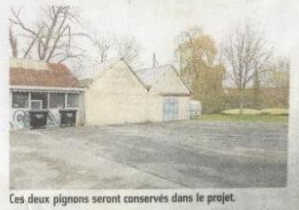
Ces deux pignons seront conservés dans le projet.
